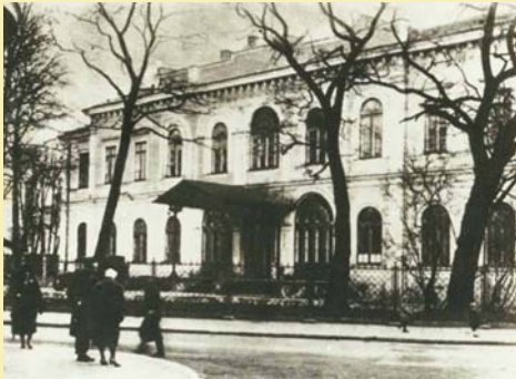
Gmach sejmu przy ulicy Wiejskiej w Warszawie, dawny budynek Instytutu Aleksandryjsko-Maryjskiego Wychowania Panien, zaadaptowany decyzją z 1918 r. na potrzeby parlamentu. Od 1925 r. rozbudowywany, w 1928 r. nastąpiła inauguracja nowej, amfiteatralnej Sali Posiedzeń
