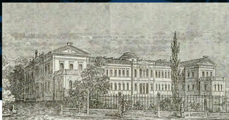
Południowa elewacja Instytutu Szlacheckiego ukończonego w 1853 r. Z czasem boczne wejście zachodnie (widoczne po lewej stronie, usytuowane w pobliżu ulicy Wiejskiej) stało się głównym.
