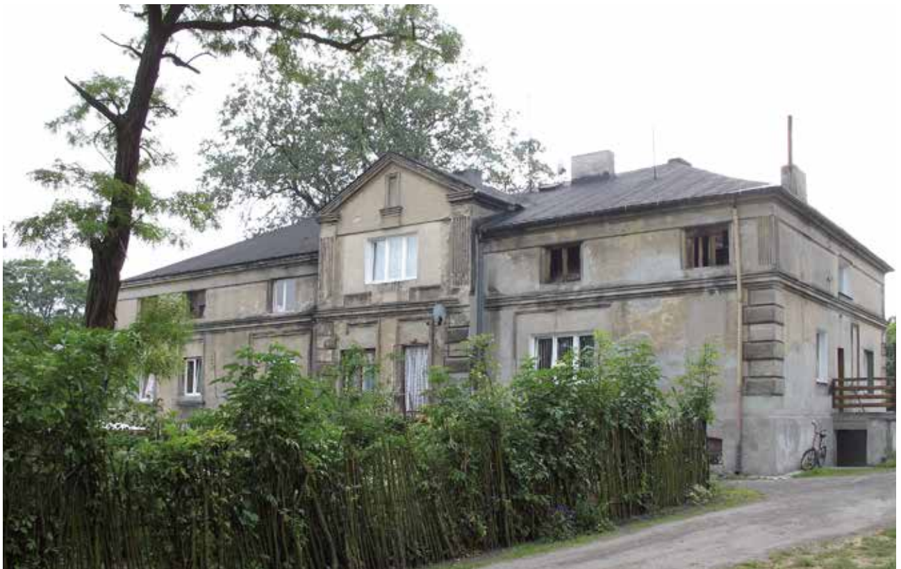
Dwór senatora Kazimierza Gruetzmachera w Czołówku, elewacja od strony parku. Stan w 2008 r. (po licznych przekształceniach). [fot. Jarosław Maciej Zawadzki]
