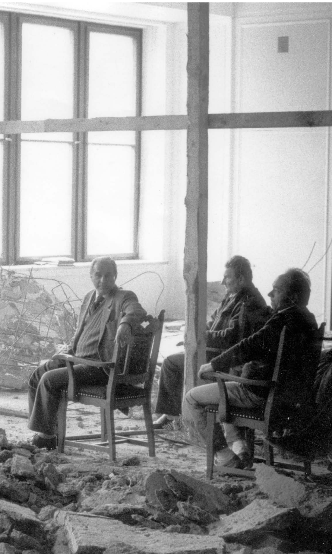
Budowa sali obrad plenarnych w gmachu Senatu, październik 1990 r. [Fot. Jacek Doktor, Kancelaria Senatu]
