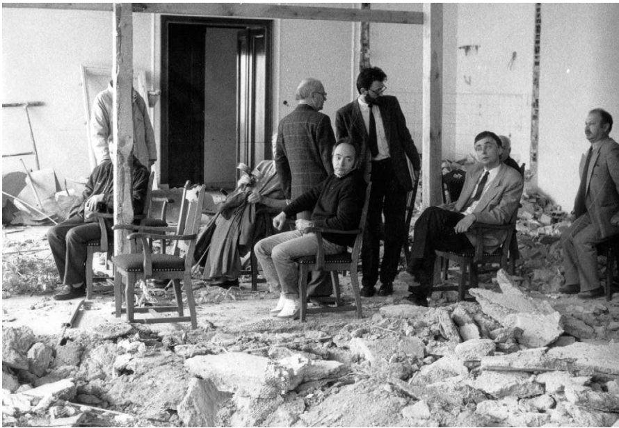
Budowa sali obrad plenarnych Senatu, październik 1990 r. [Fot. Jacek Doktor, Kancelaria Senatu]
